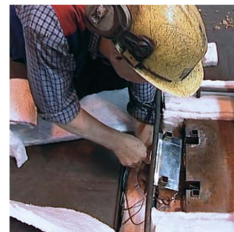
12. 性能测试。测试专用的物料投入炉内处理，并记录考核指标相关的数据。
