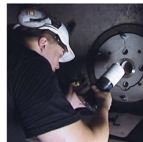
9. 接下来开始安装无焰烧嘴，热电偶
