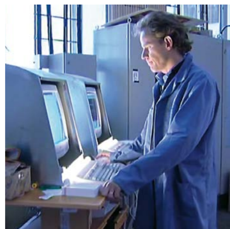
2. 在UTAB监控下，对烧嘴和控制系统进行离线预测试。
