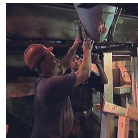
5. 为节省时间和人力，现场砌筑新的炉子内衬。
