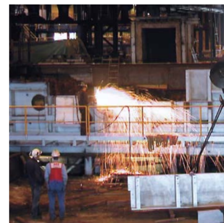
4. 炉墙和炉顶需要拆除，对现有烧嘴进行泄漏测试和压力控制测试。
