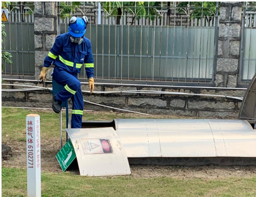
(2) 中控人员穿戴好劳保用品，关闭污水总阀，防止甲醇流入市政污水管网。
